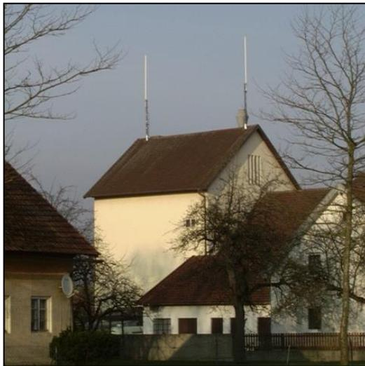
**Abb. 1:** Beispiel für eine Mobilfunksendeanlage mit omnidirektionalen Antennen.
