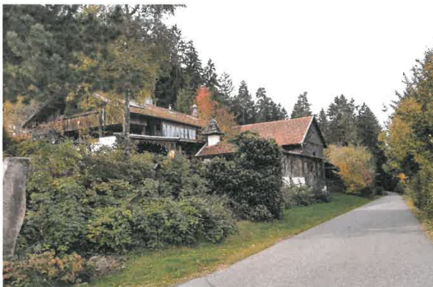
Denkmalgeschütztes Gebäude Neurandsberg 17, Blick nach Norden
